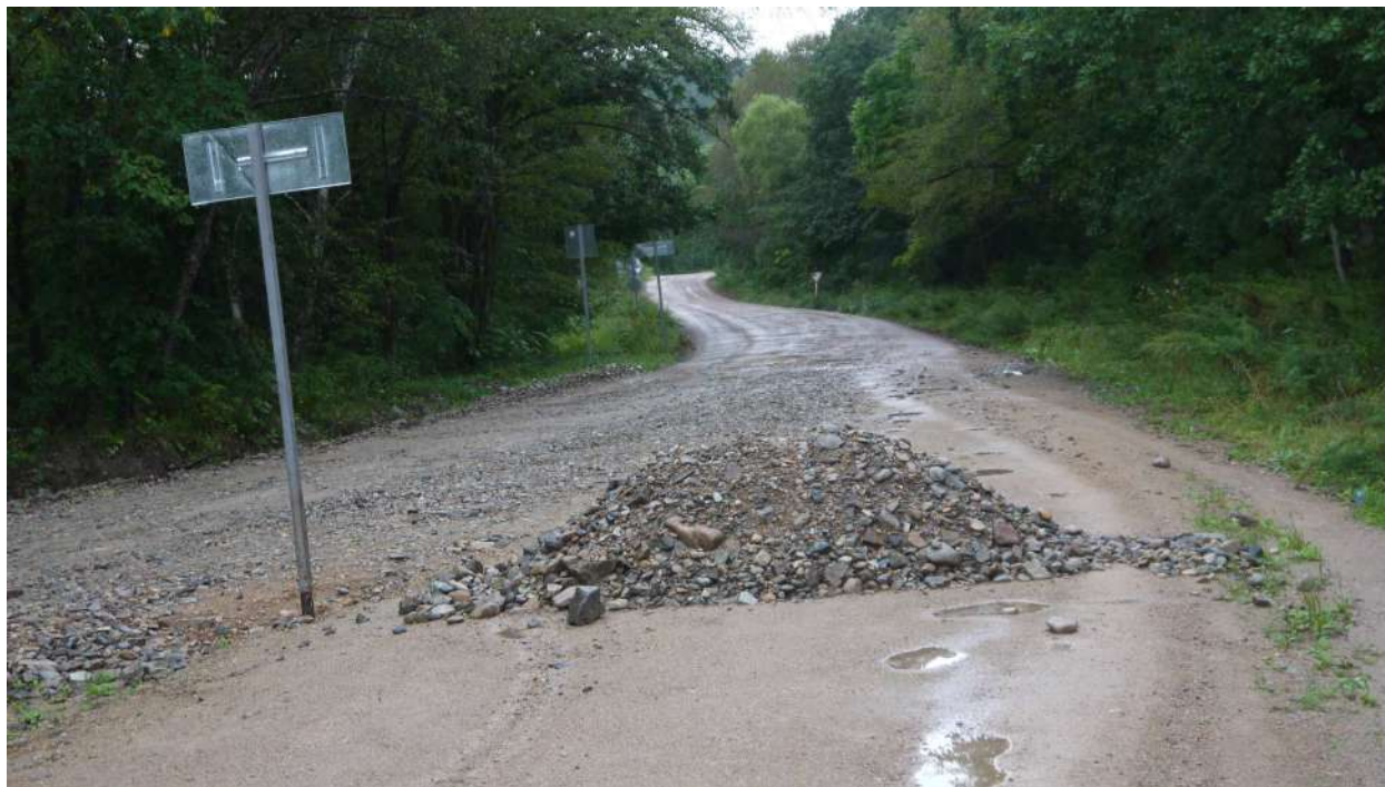
Фото 1 Подходы к мосту через реку Лиственная (вид на начало автодороги Маргаритово – Моряк-Рыболов)
