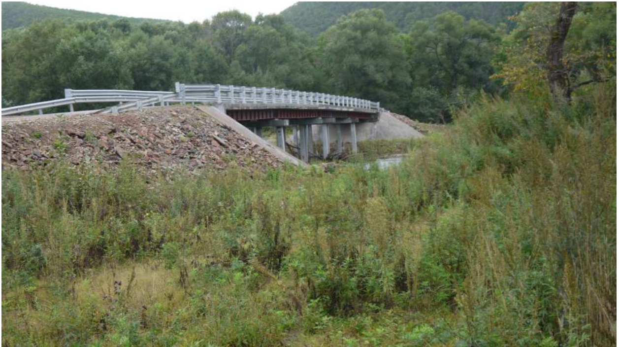
Фото 14 Автодорожный мост через реку Маргаритовка на км 3+500м автодороги Маргаритово - М оряк-Рыболов
