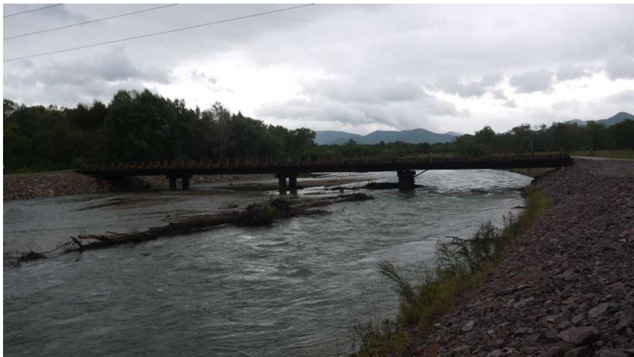
Фото 6 Мост через реку Маргаритовка (вид с низовой стороны)
