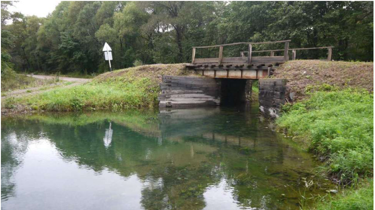
Фото 16 Мост через левобережную протоку на км 1+300м автодороги Маргаритово - Моряк-Рыболов
