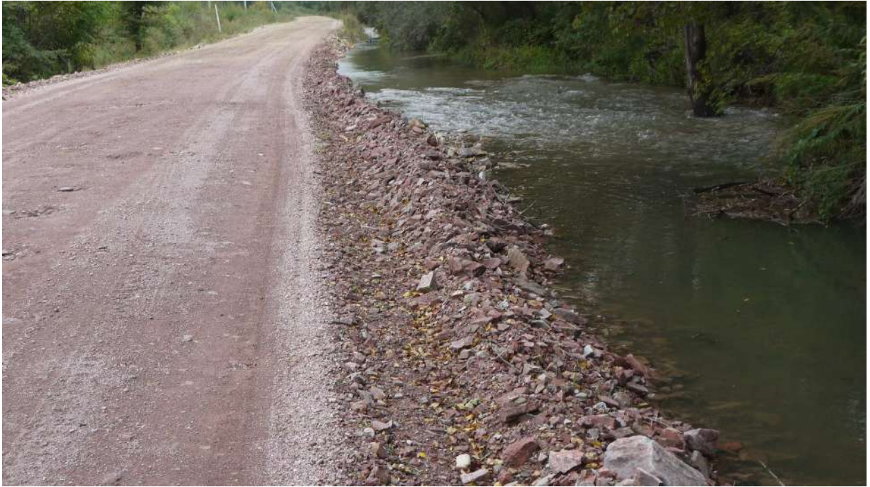
Фото 22 Участок размыва дороги на 3км автодороги Маргаритово - Моряк-Рыболов (вид верховой стороны)
