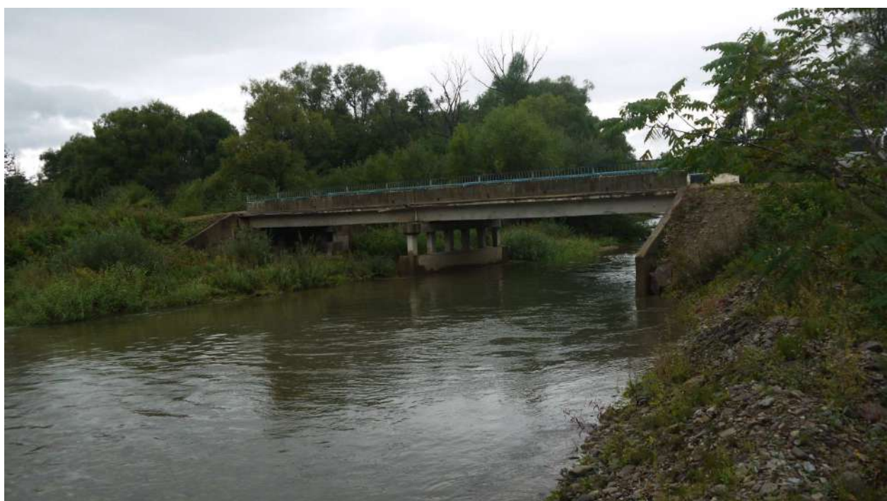
Фото 19 Мост через протоку на км 1+560м автодороги Маргаритово - Моряк-Рыболов (вид вверх по течению)
